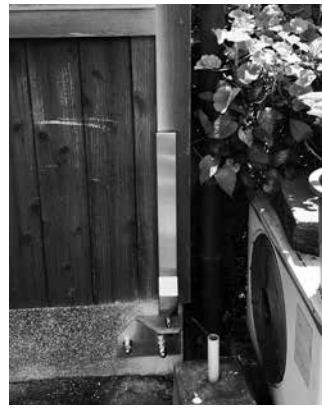
写真4 家の角部4か所に外付けホールダウン金物
