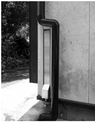
写真4 家の角部4か所に外付けホールダウン金物
