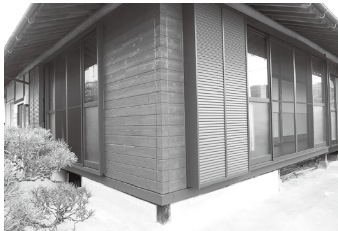
写真3 改修後、有筋基礎を打設し耐震補強壁新設
