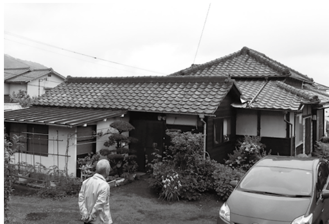
写真1 築60年の土壁作りの平屋
